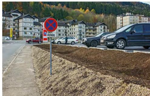
Abgetreppte Mulde bei fallendem Gelände mit Zwischenbermen.
