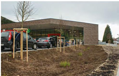
Ausgerundetes Trapezprofil als einfachste geometrische Form, nach der mehr als 90% der Sickermulden gebaut werden.
