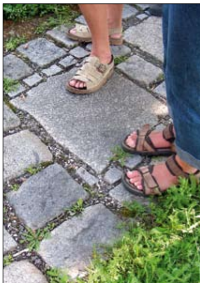
Abb. 14: Wir lernen beim Gehen. Natursteinpflaster mit Sandfugen im Schaugarten Luger in Buchkirchen bei Wels.
